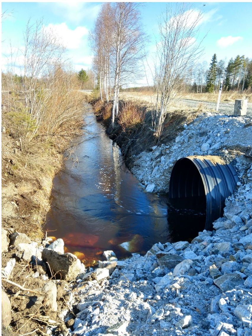
Kuva 2. Isoluiskan vedet ohjataan tienalitusrummun kautta allasjärjestelmään
